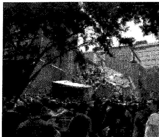
**Figura 7: Edificio colapsado por “Piso débil”**
